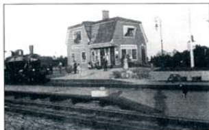
Västerhaninge station i början av 1900-talet. Bilden finns med i boken Västerhaninge i gamla och nya bilder .
